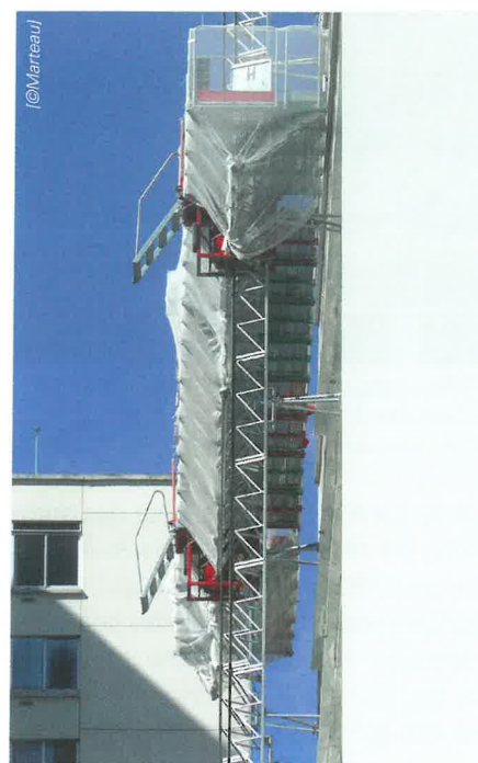
Au rez-de-chaussée, les plates-formes à crémaillère, ne pouvant être installées sur les terrasses des différents équipements, ont pris appui sur des consoles fixées sur les façades. Cette partie de l'ouvrage a ensuite été traitée avec du bardage.
