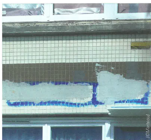
Dans un premier temps, les zones dégradées ont été réparées à l'aide d'un enduit spécifique, les aciers corrodés passivés et traités.
