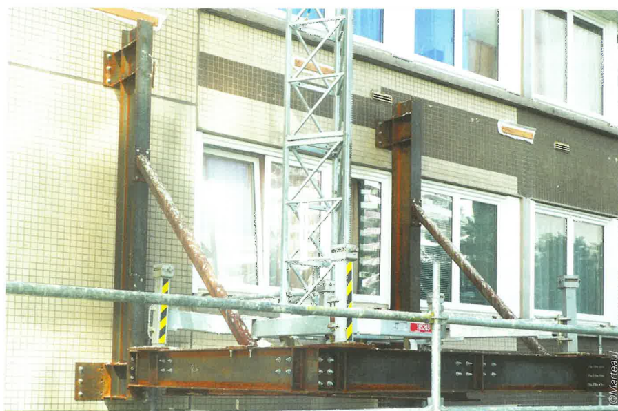
Au-delà du rez-de-chaussée, les mâts des plates-formes motorisées ne pouvaient être ancrés dans les façades, les reprises de l'isolation laissant, après coup, des traces visibles. L'ancrage a donc été réalisé au niveau des fenêtres.
