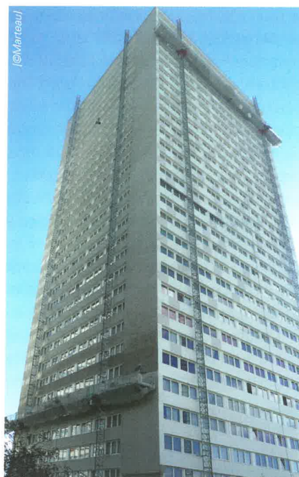
La hauteur importante des bâtiments (100 m) imposait le choix de plates-formes à crémaillère.
