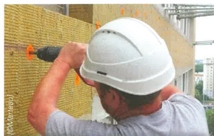
Pour éviter le confinement, le pisto-scèlement a permis de fixer l'isolant dans la maçonnerie sans dégagement de poussières.
