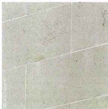
Aspect de la vêtiture après la mise en œuvre des joints.
