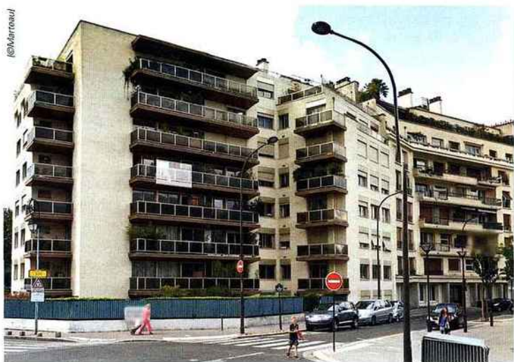
A Boulogne, une construction de standing était mal isolée avec des parements, qui avaient subi un demi-siècle de pollutions.
