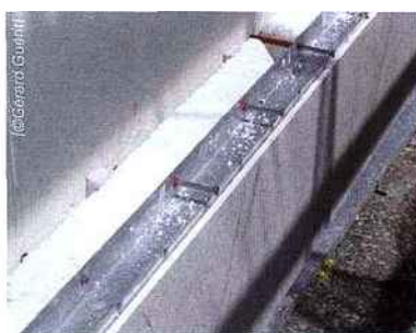
Chaque rang de vêtements a été rendu solidaire du support par l'intermédiaire de rails de fixation.
