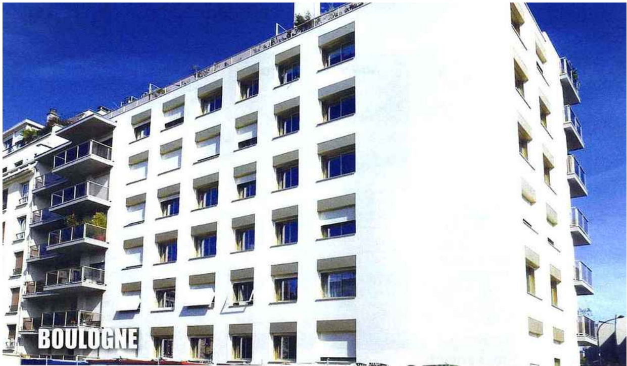
Façade de l'immeuble après la rénovation. L'aspect fini est très proche de l'aspect d'origine.
