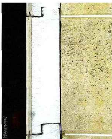
Coupe sur l'assemblage vertical des vêtements.
